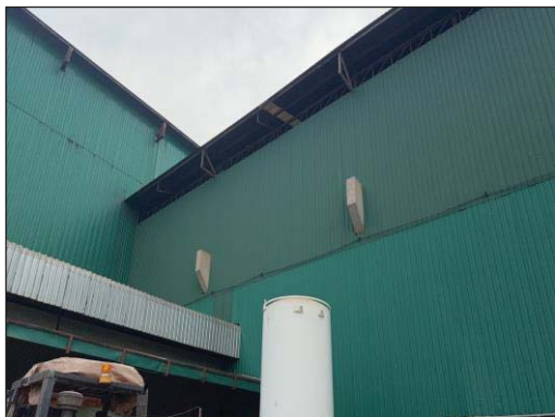
ภาพที่ 31 ช่องลมระบายอากาศของอาคารผลิต
